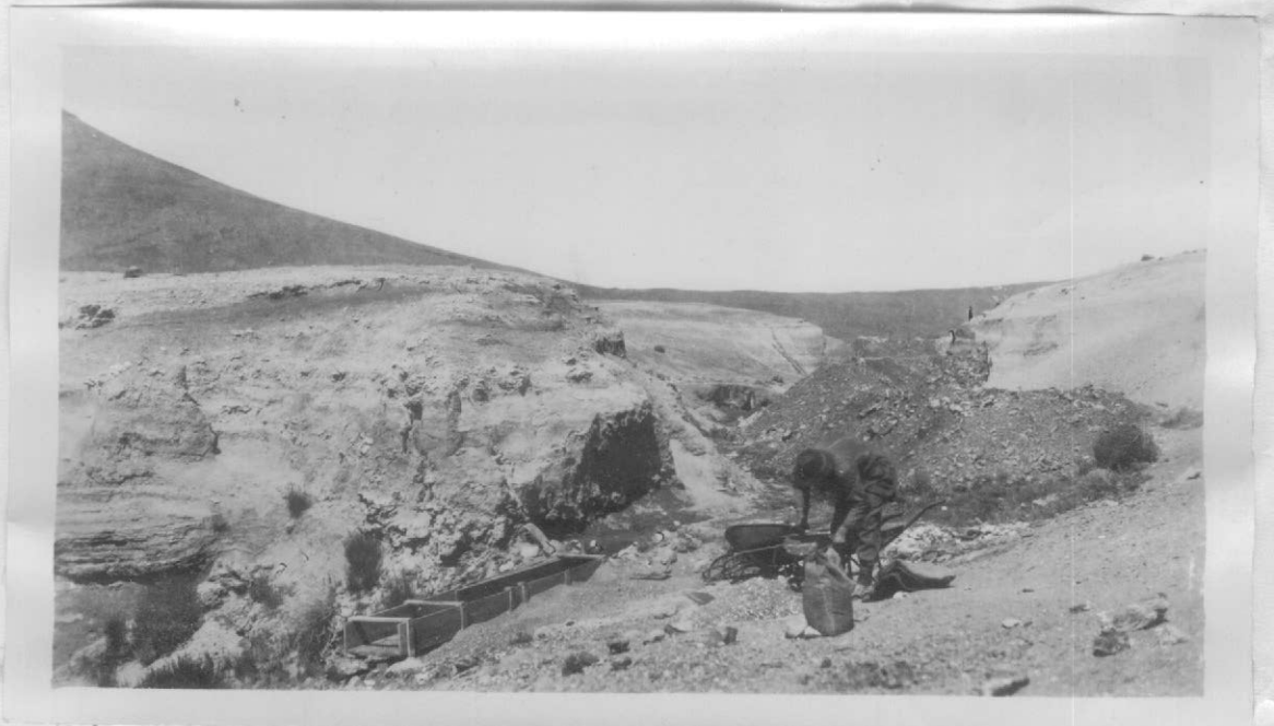
Fig. 2 Foto 4. Lavadero primitivo de la mina Victoria, utilizando el agua del arroyo Huayelón.
